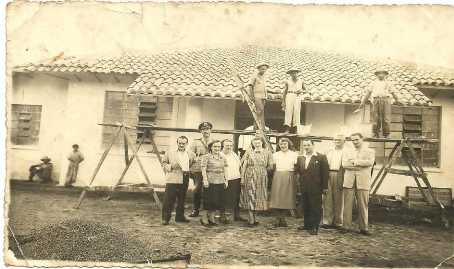
Figuras 14 e 15 – Parque Infantil Décio Medeiros Pullin em fase final de sua construção e após construído
