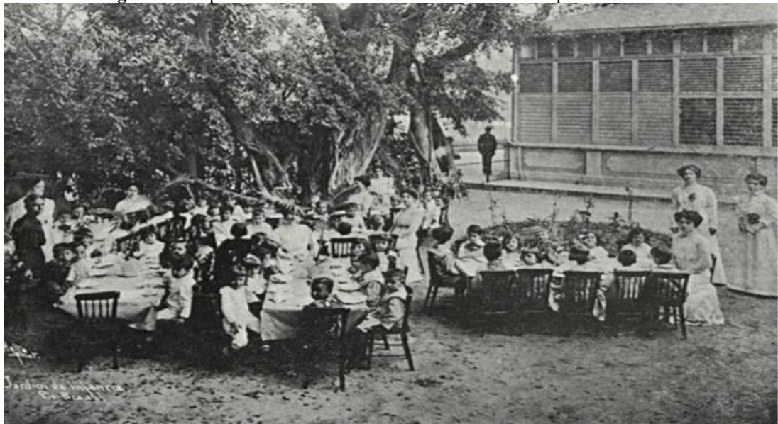
Figura 8 – Aspecto de atividade do Jardim de Infância Campos Salles
