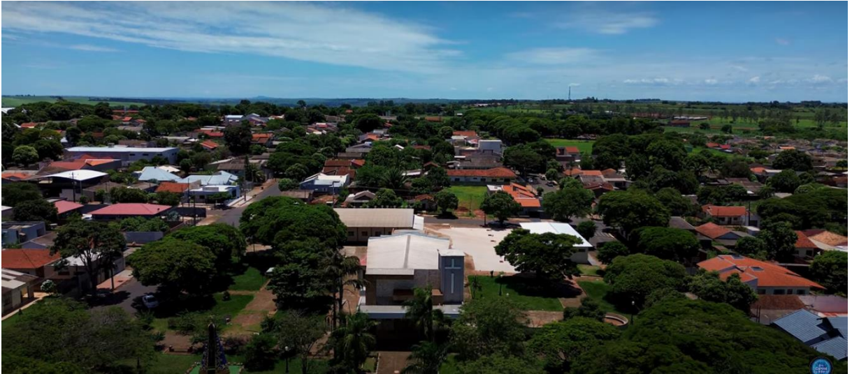
Figura 7. Imagem aérea da praça da Igreja ano de 2022.
